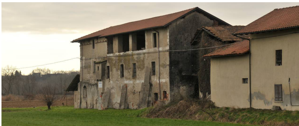
La manica sud-est del complesso di "Cascina Monastero", con l'abside semicircolare della chiesa di S. Pietro
